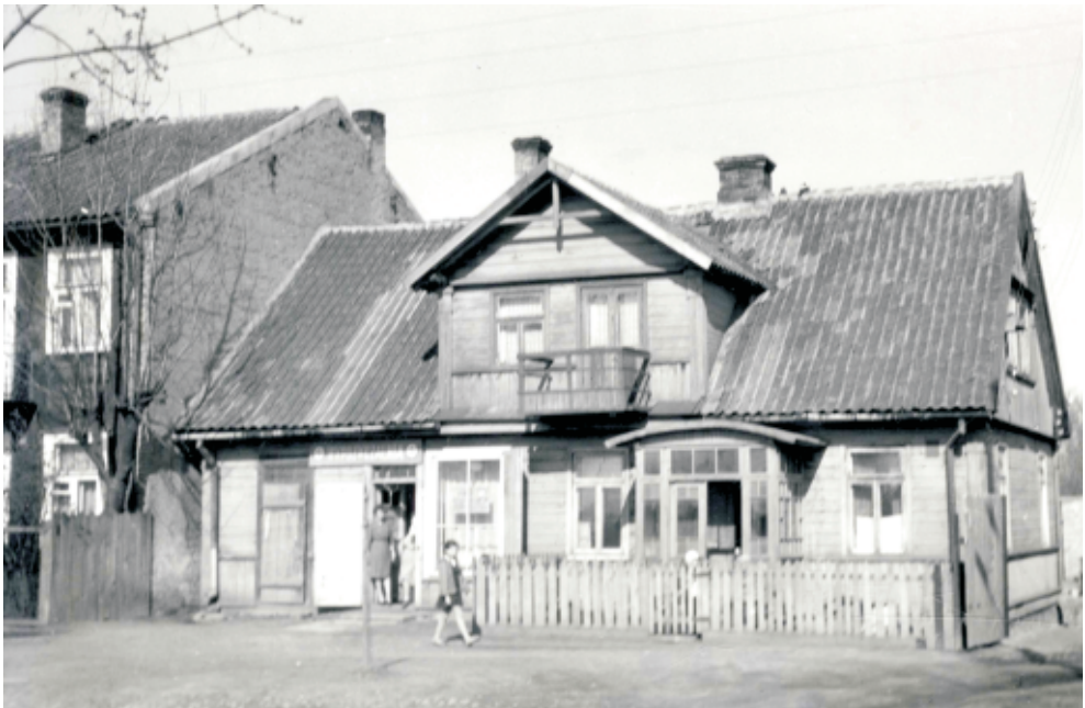
Dom przy ul. Wasilkowskiej 21 w Białymstoku, w którym mieściła się piekarnia, spełniająca również funkcję tajnego przejścia do siedziby Okręgowej Komisji Oświaty i Kultury. Na górnej kondygnacji budynku tajne lekcje prowadziła Eugenia Krassowska; Materiały Marii Kolendo (1912-1980) , zespół numer 750, sygnatura 154-11.
